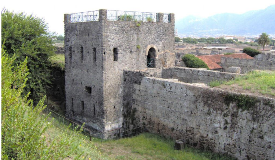
Fig. 5. Torre di Mercurio e cinta muraria, dettaglio vista dal lato nord (foto agosto 2016)
