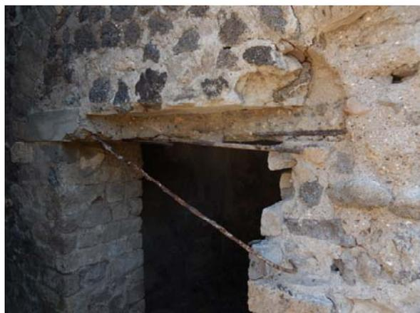
*Piattabande in c.a. con espulsione di copri ferro e ossidazione delle armature (casa di Fusco Regio VIII, 2)*
