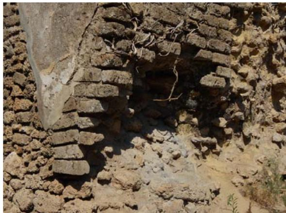
*Particolare del degrado delle murature sul fronte meridionale (Regio VIII, 2)*
