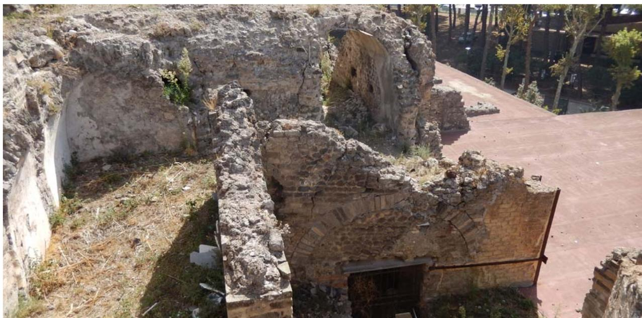
*Degrado delle murature e delle coperture voltate al disopra delle Terme del Sarno (Regio VIII, 2)*
