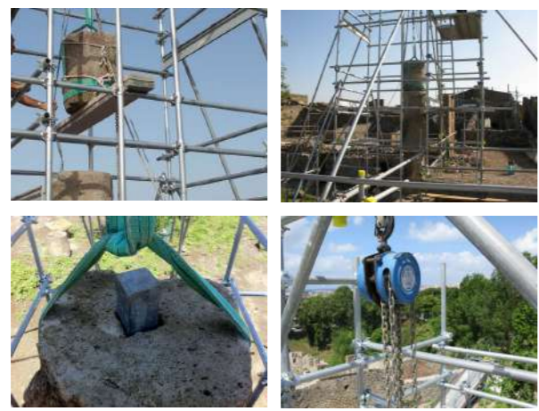
POMPEI SCAVI - GPP CASA DEL MARINAIO Impresa FORTE srl Ricomposizione colonne
