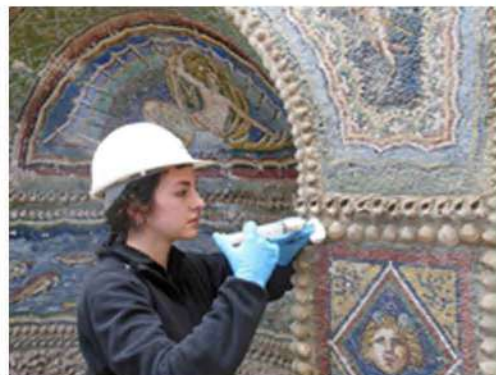
Inserimento di malta Ledan (Casa dell'Orso Ferito, restauro L'Officina)
