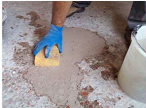
Stuccatura con NHL5 e cocchiopesto (casa del Principe di Napoli, L'Officina)
