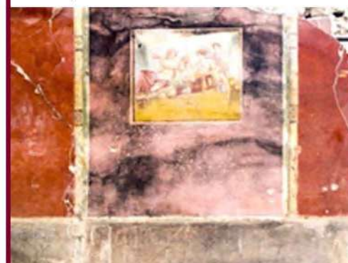
Affresco con efflorescenze saline (Casti Amanti; Civ.6 amb L)
