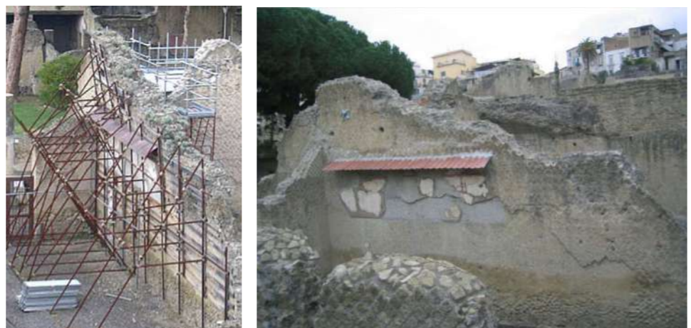
CANTIERE Scavi di Ercolano - Palestra - IMPRESA FORTE COSTRUZIONI SRL Il tratto di muro sommitale prima e dopo l'intervento di riappiombatura
