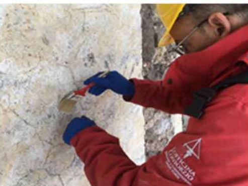
Applicazione di nanosilice su intonaco decorato e umido (Villa dei Papiri)
