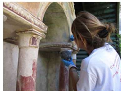
Messa in sicurezza (Pompei, casa del Principe di Napoli, restauro L'Officina)
