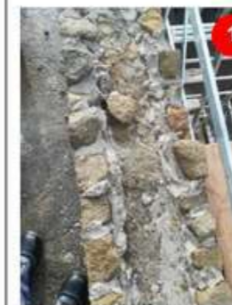
1 Rimozione materiale cedevole e creazione sede alloggiamento
