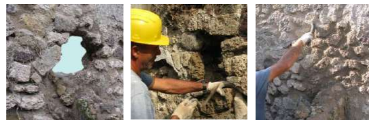
FASE 3 - CROLLO DI PORZIONI MURARIE : RIPRISTINO MURARIO A SPESSORE
