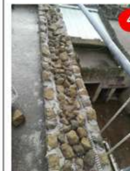
4 Allettamento del primo strato di materiale lapideo
