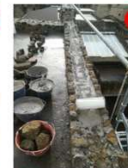
2 Posizionamento del primo stato di rete in fibra di vetro
