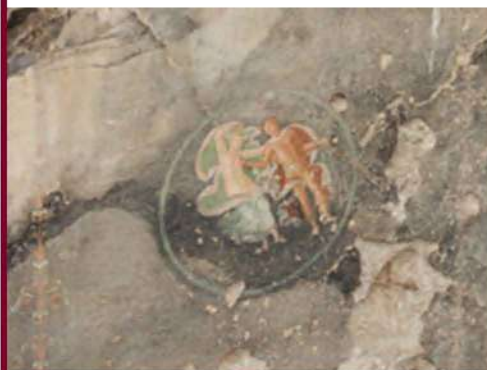
Pareti dipinte che richiedono puliture complesse (Pittori al lavoro, amb.U)
