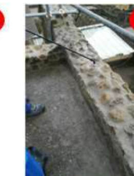
6 Trattamento superficiale protettivo finale
