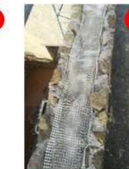
3 Allettamento del primo stato di rete in fibra di vetro
