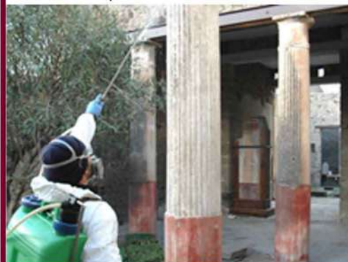
Trattamento con biocida a rilascio lento (casa del Frutteto, L'Officina)
