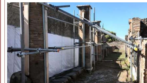
Cantiere : Pompei Regio VII GPP - Impresa Forte srl Puntellature e cerchiature di colonne
