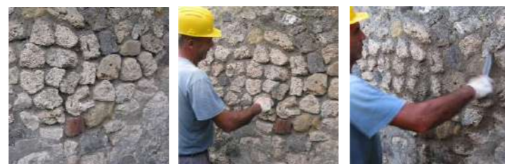
FASE 1 - DILAVAMENTO DELLE MALTE : REVISIONE E RIPRISTINO DEI GIUNTI
