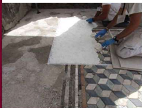
Trattamento con ossalato d'ammonio (Casa del Fauno, L'Officina 2016)
