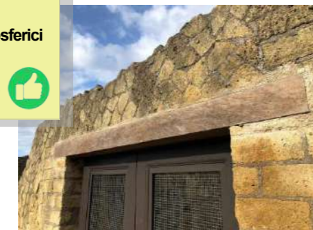
Ercolano Scavi - Cantieri Forte srl Posa in opera di architravi in azobé
