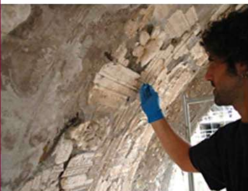
Messa in sicurezza (Ercolano, Arco Quadrifronte restauro L'Officina)
