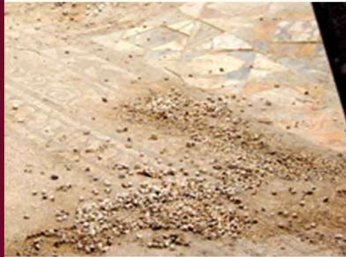
Tessere distaccate a rischio di perdita (Casti Amanti, ambiente U)
