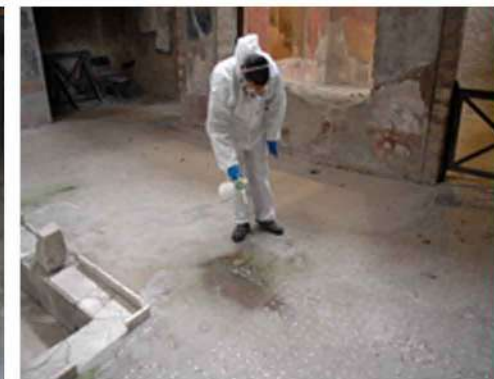
Trattamento con biocida a rilascio lento (casa Sannitica, L'Officina)
