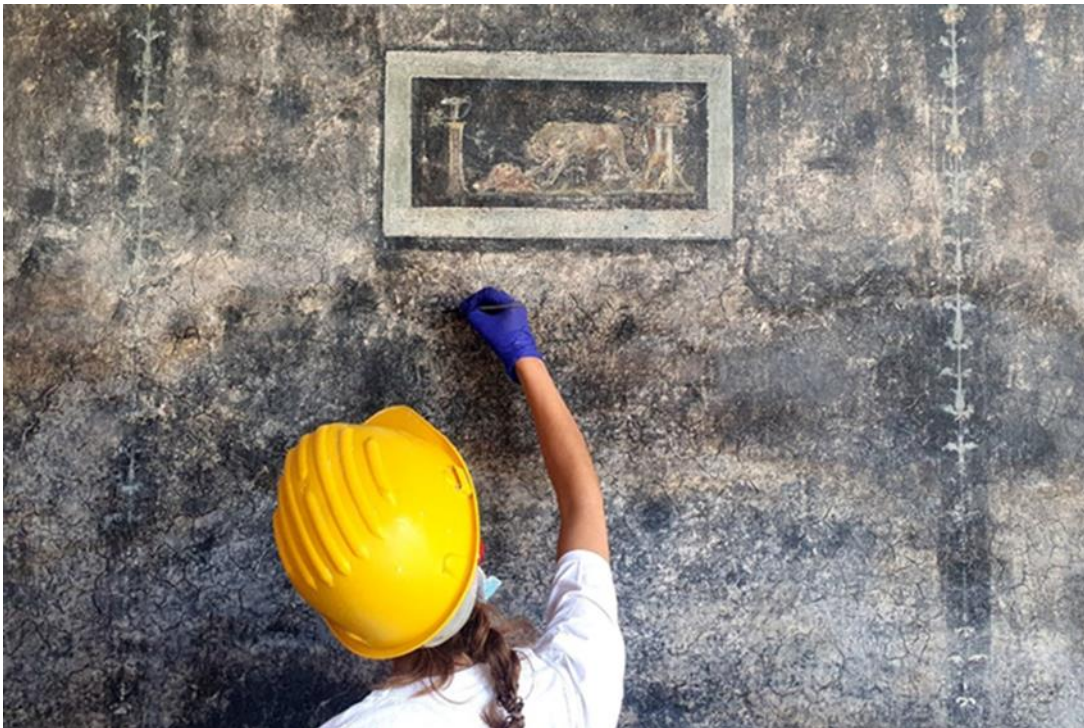
2. Cantiere di restauro
