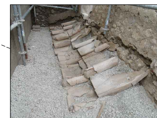
Tetto a protezione della latrina.
