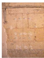
1. Individuazione del giunto e posizionamento dei riferimenti.
