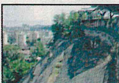
Intervento di sistemazione tramite rete fibrata e micropili e spritz beton
