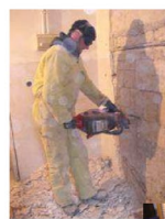
3. Taglio del giunto tramite sega circolare con eccentrico.
