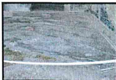
Fratture di tensione nella pavimentazione di Villa Arianna
