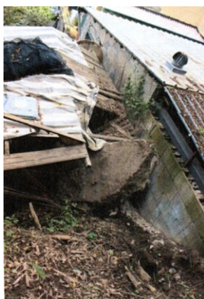
2001: crollo della porzione di pavimento in ciottolato che ha interessato le strutture sottostanti
