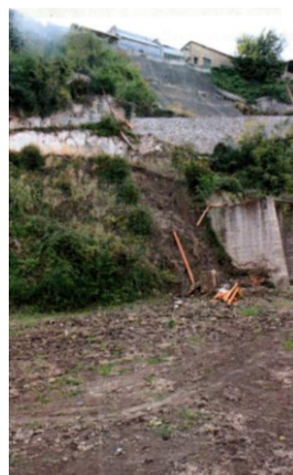
Fig. 25: Crolli e colamenti che interessano anche strutture archeologiche sepolte e locali accumuli di fanghi e detriti
