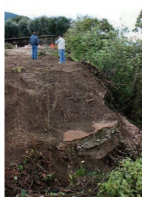
Porzioni di muratura e vegetazione sospese sul pendio in procinto di franare
