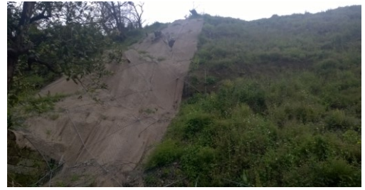
Graticciata metallica e tessuto che copre solo parzialmente il versante in frana
