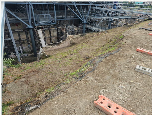
FIG. 3 Area di scavo, parziale della scarpata. Da ovest.
