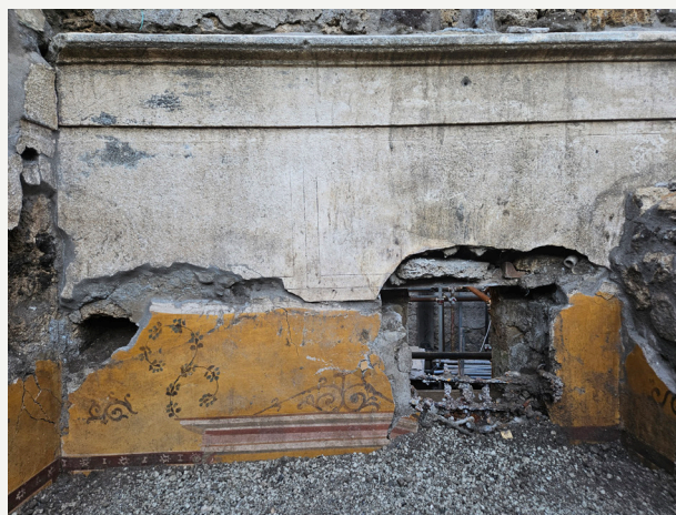
FIG. 30 Ambiente B1, parete est. Scavo grata in ferro. Da ovest.
