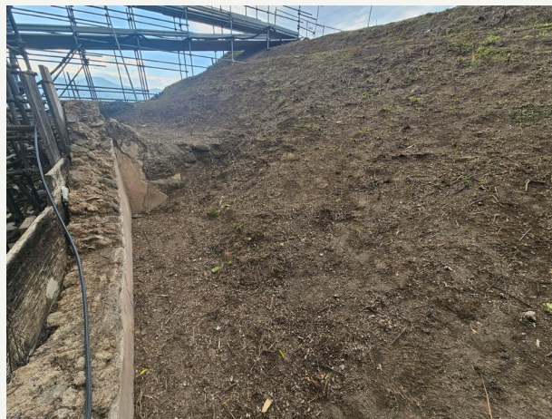
FIG. 4 Area di scavo, parziale della scarpata. Da est.
