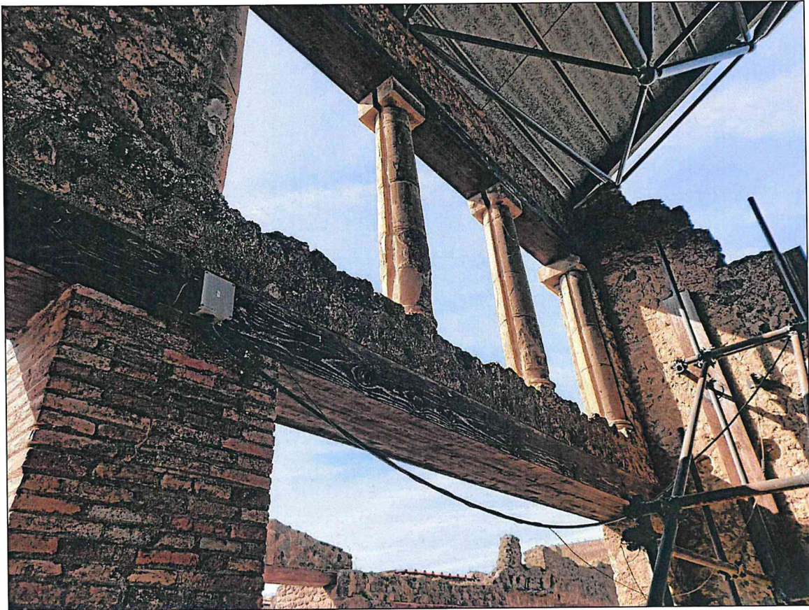
Figura 4 Prospetto interno (sud-est), particolare
