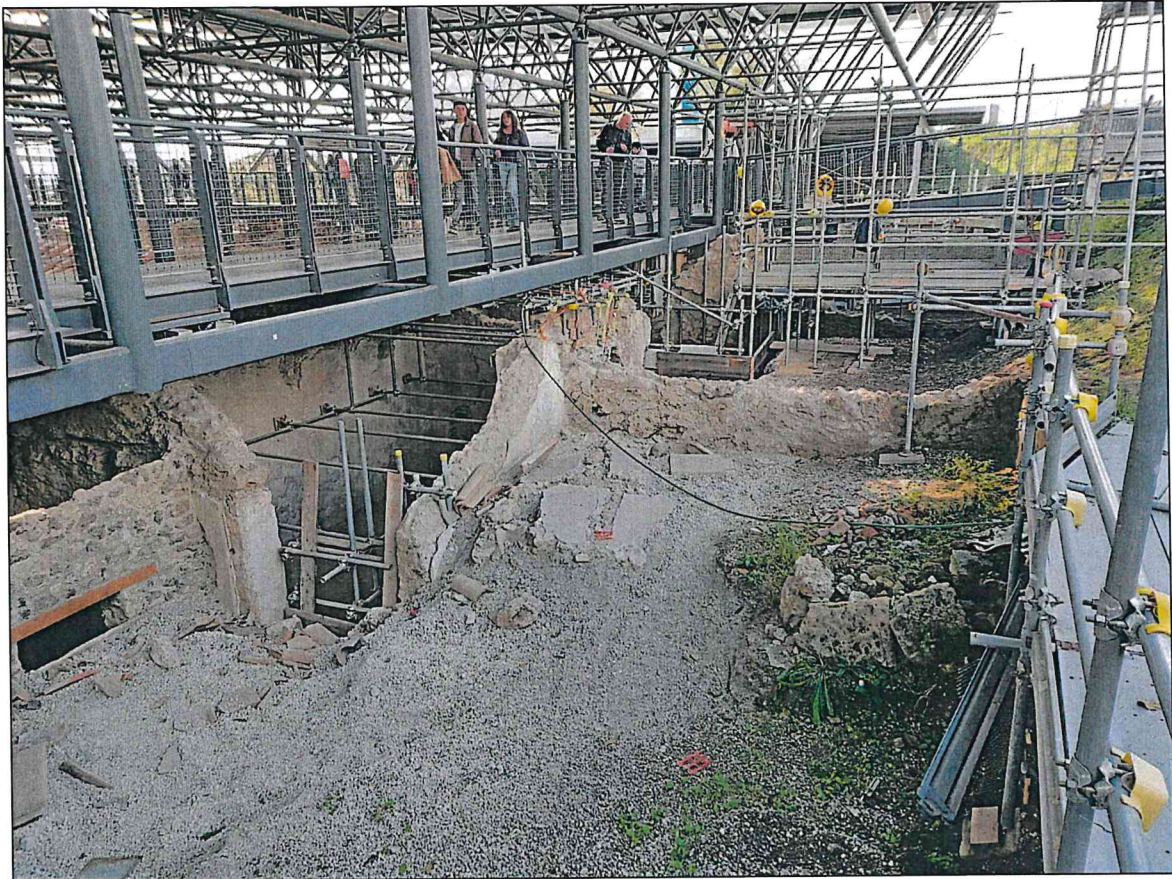
Figura 5 Fronte di scavo lato nord, particolare
