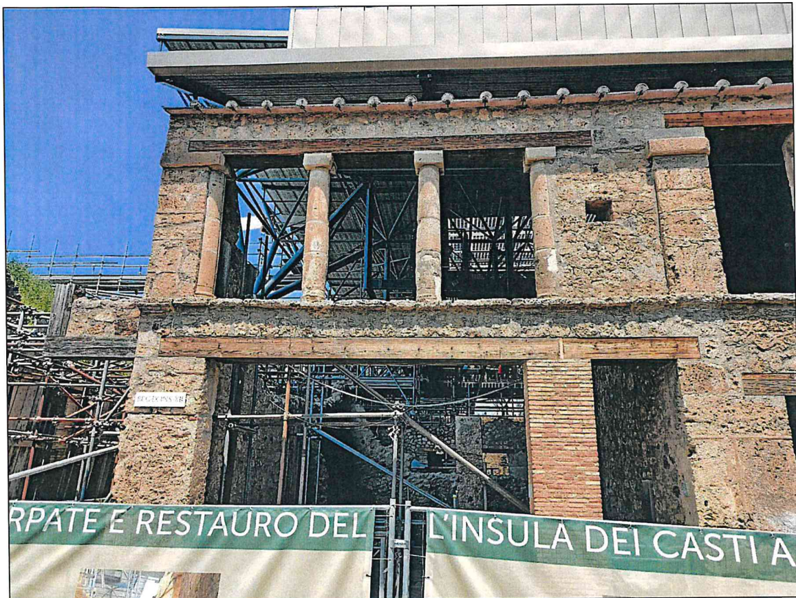
Figura 3 Prospetto nord-ovest su via dell'Abbondanza (in corrispondenza del civ. 1-2), in corso dei lavori
