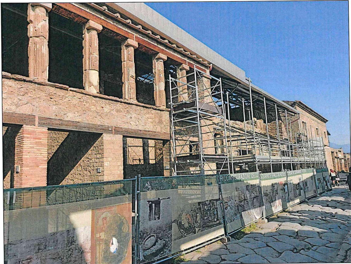
Figura 4 Prospetto nord-ovest su via dell'Abbondanza
