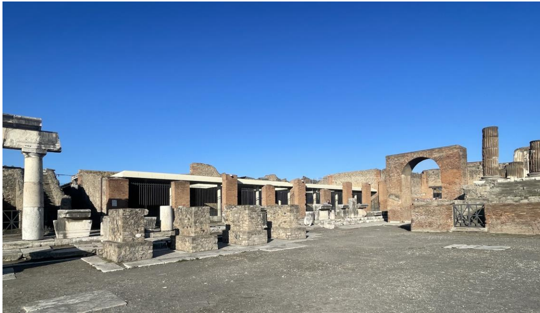
Nuova copertura deposito pubblico vista dal foro
