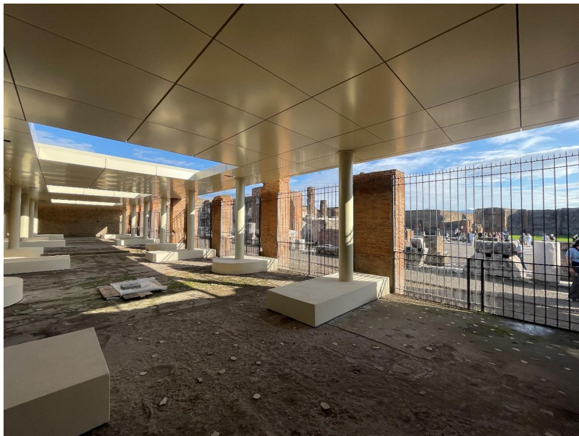
Nuova copertura deposito pubblico vista dall'interno del deposito pubblico
