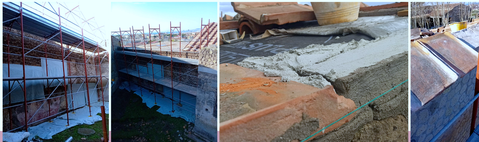
Lavori di messa in sicurezza delle strutture di Villa San Marco
